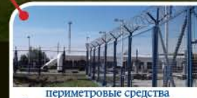
периметровые средства обнаружения, работающие на двух различных физических принципах
