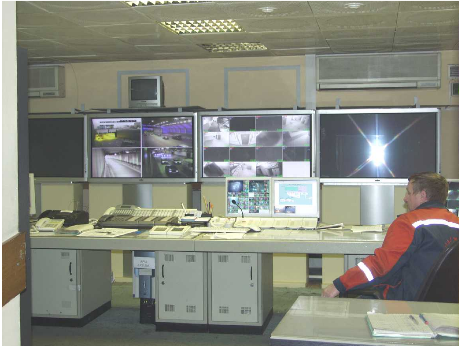
Рисунок 106 Центральный пост управления АСУ ФЖБ
