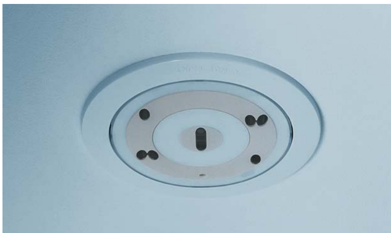
Рисунок 4. Мультисенсорный пожарный извещатель FAP-OC 520
