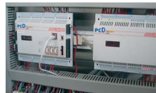
Программируемый логический контроллер PLC с МР интерфейсом поставлен SAIA-Burgess Controls
