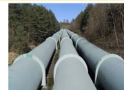
Станции обслуживания трубопроводов
