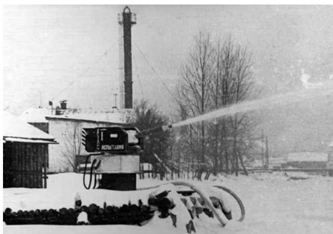
Рис. 1.7. Испытания пожарного робота в 1983–1984 гг.
