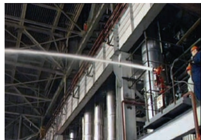
Рис. 10.14. Пожарный робот орошает перекрытие машинного зала Петрозаводской ТЭЦ
