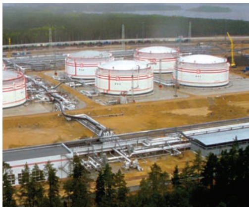
Рис. 9.11. Нефтяные терминалы «Лукойл-2» (г. Высоцк Ленинградской области)
