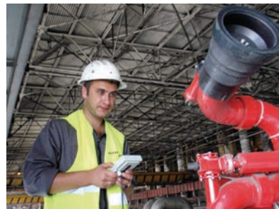
Рис. 10.15. Кураховская ТЭС. Пусконаладочные работы
