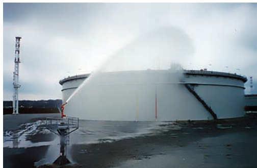
Рис. 9.15. Лафетный ствол с осциллятором охлаждает резервуар РВС-100000
