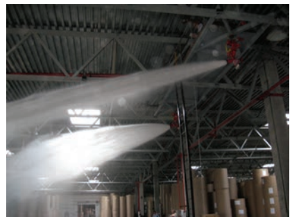
Рис. 10.50. Пожарные роботы на Рубежанском КТК
