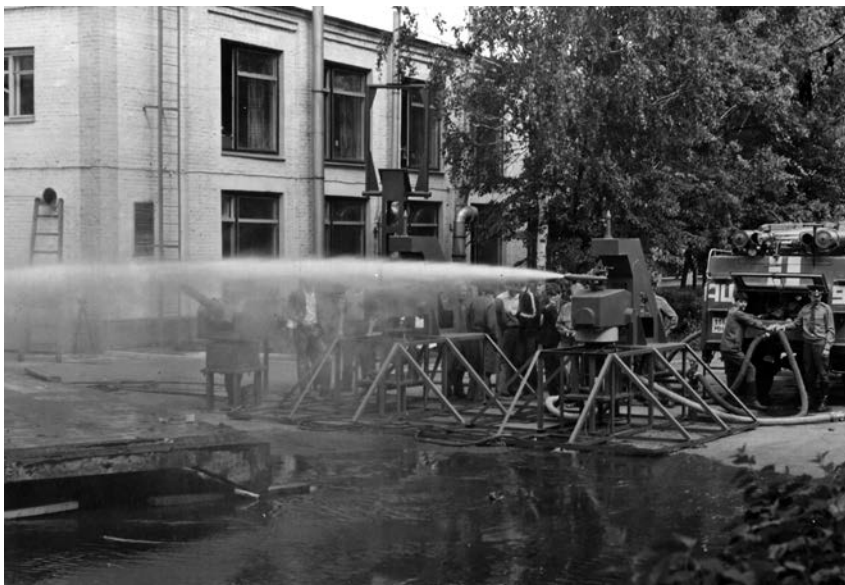
Рис. 1.10. Испытания гидромониторов перед отправкой в Чернобыль
