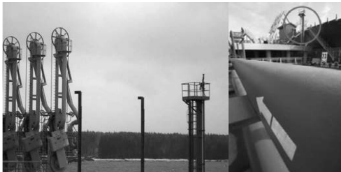
Рис. 9.10. Балтийская трубопроводная система (г. Приморск)
