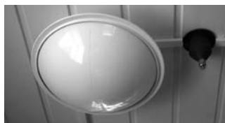
Рис. 6.13. Фрагмент автономной установки порошкового пожаротушения для защиты строительной бытовки.
