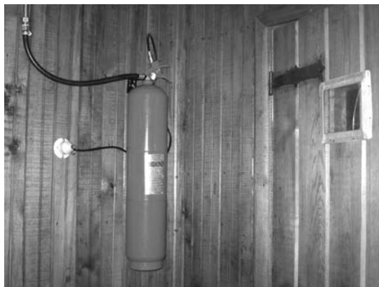
Рис. 9.2. Пример практического использования автономного комплекса на базе ручного огнетушителя для защиты бани.
