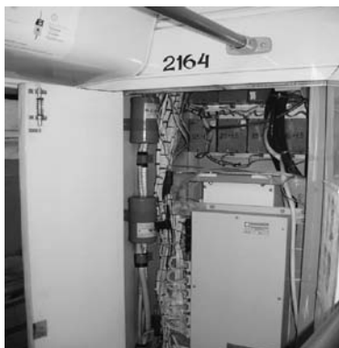
Рис. 7.10. Защита электрического шкафа трамвая генераторами огнетушащего аэрозоля.
